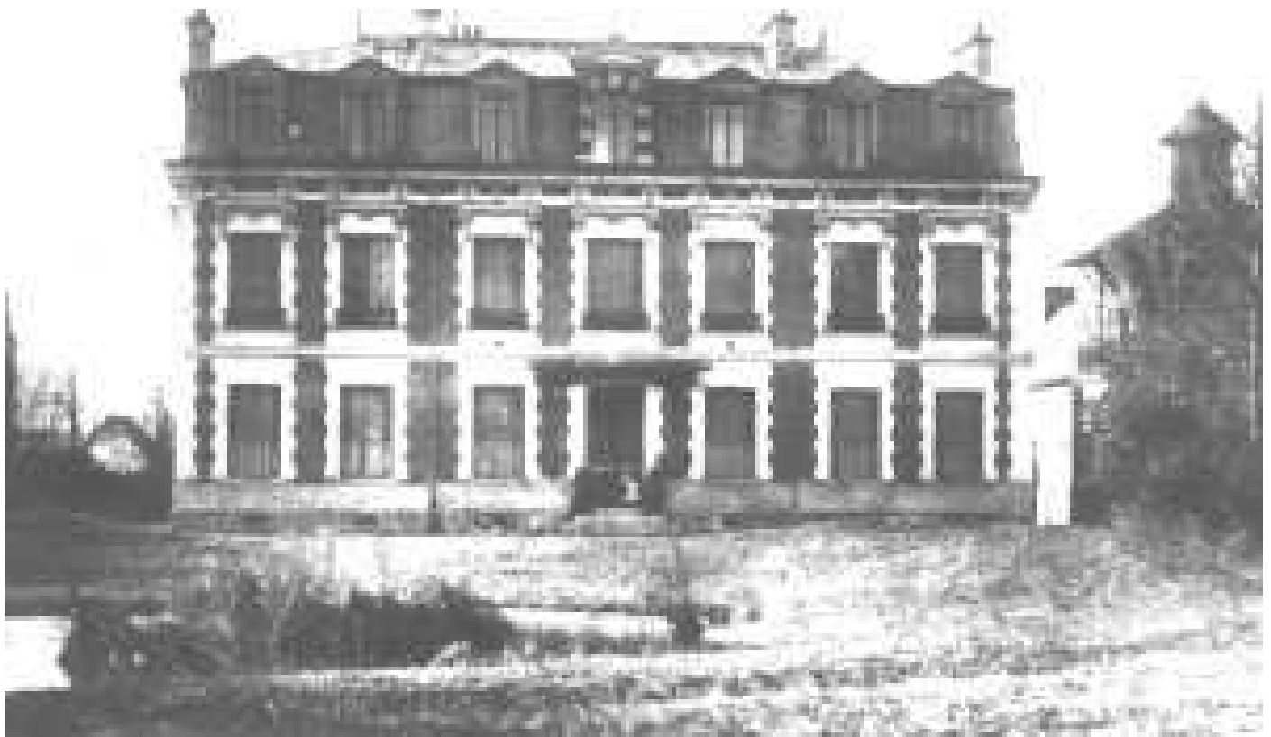
L'arrière du Château avec en premier plan le Bassin
